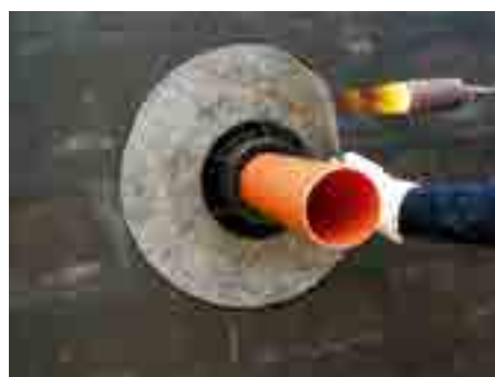
5. Pielīmēt membrānu pie sienas bitumena seguma.
