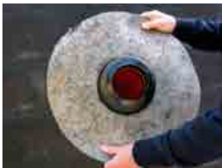
2. Uzstādīt hidroizolācijas membrānu.
